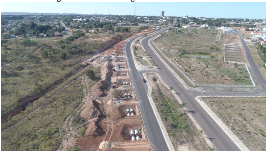
Figura 2. Obras de Drenagem Pluvial do ano de 2020.
