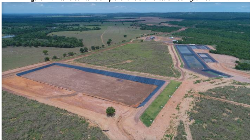
Figura 11. Aterro Sanitário em pleno funcionamento, em de Água Boa – MT.
