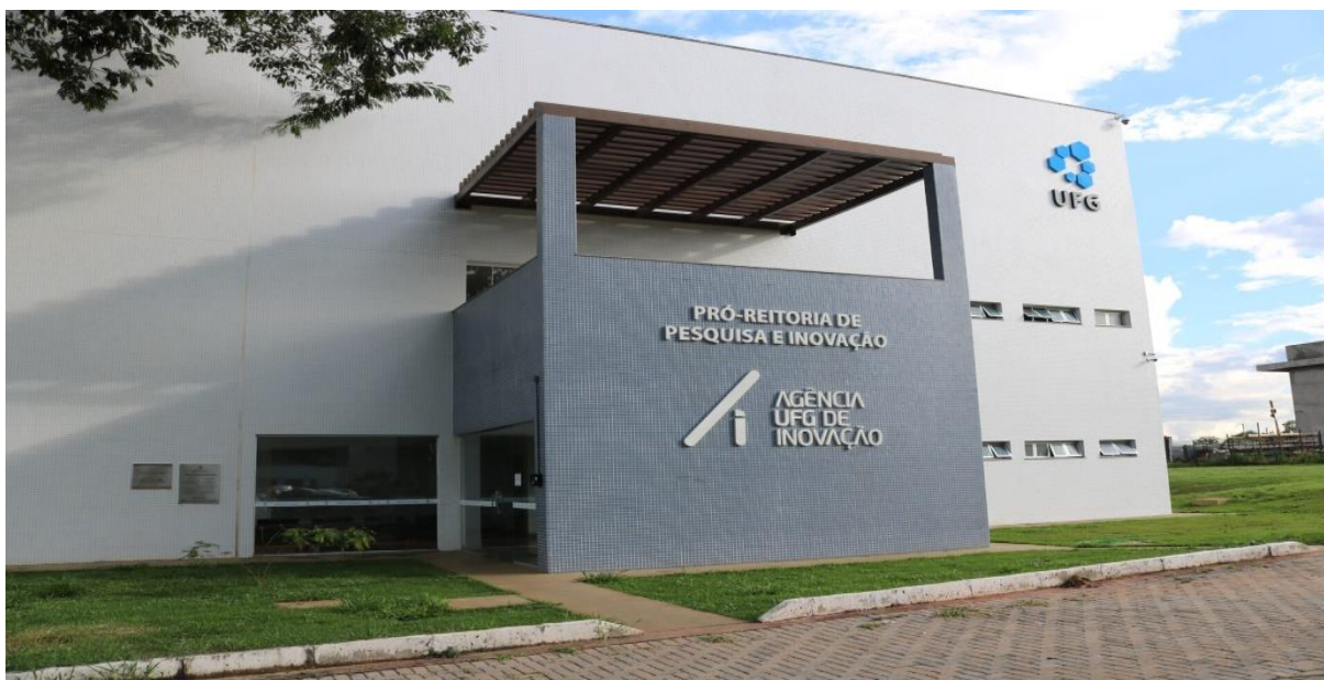
Figura 5: Foto da instalação da PRPI e da Agência UFG de Inovação/PTS/UFG
