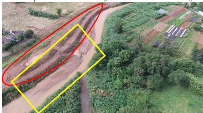
Figura 17 – Intervenções no Encontro das águas: Rio das Antas e Córrego Água Fria
