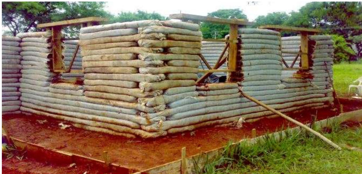
Figura11:Camadas e volumetria do superadobe
