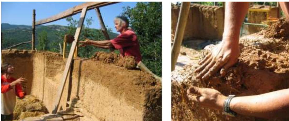
Figura12:Aplicação e acabamento do cob
