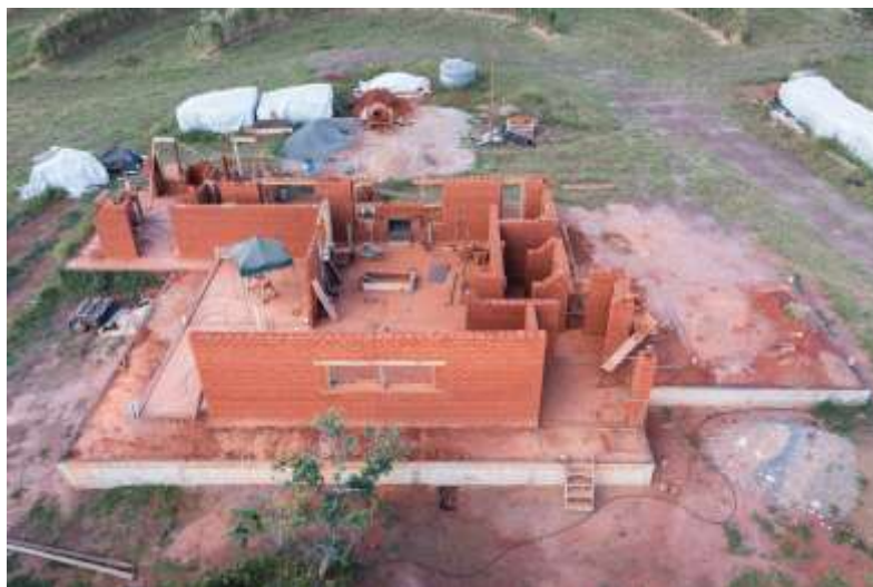
Figura15: Residência em construção com paredes em adobe.
