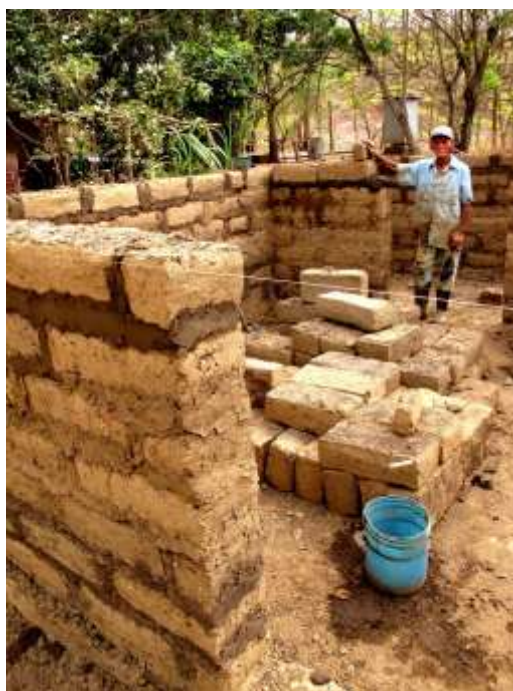
Figura9: Processo e aplicação do adobe
