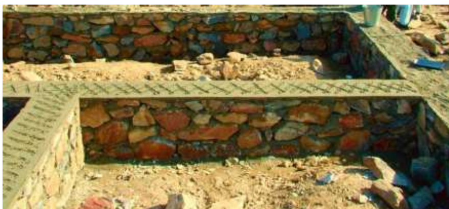
Figura 6: Uso de pedra em fundações
