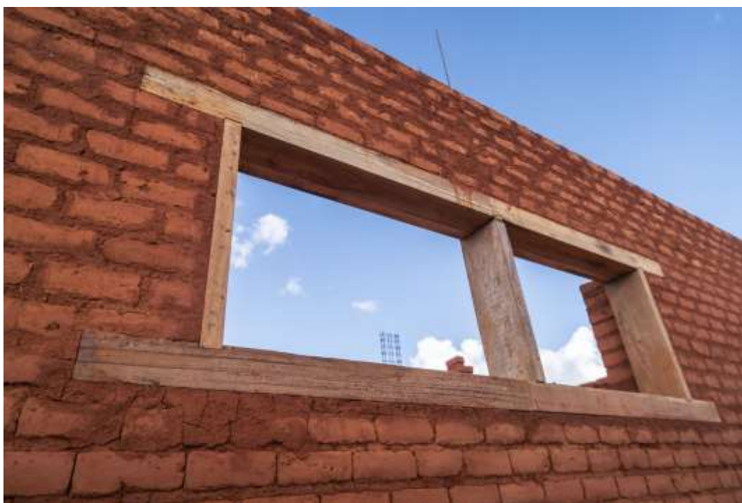
Figura19: Janela em madeira de demolição.
