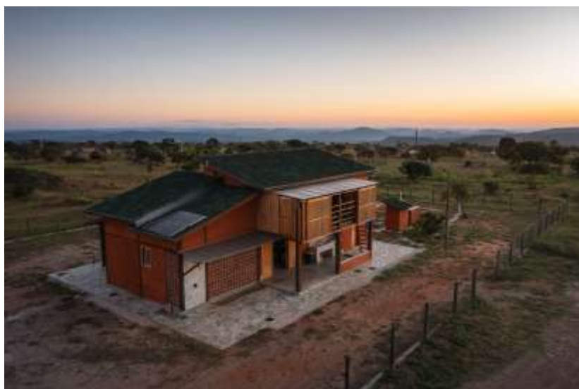
Figura16: Residência construída com paredes em adobe, reboco e pintura naturais e madeira de demolição.
