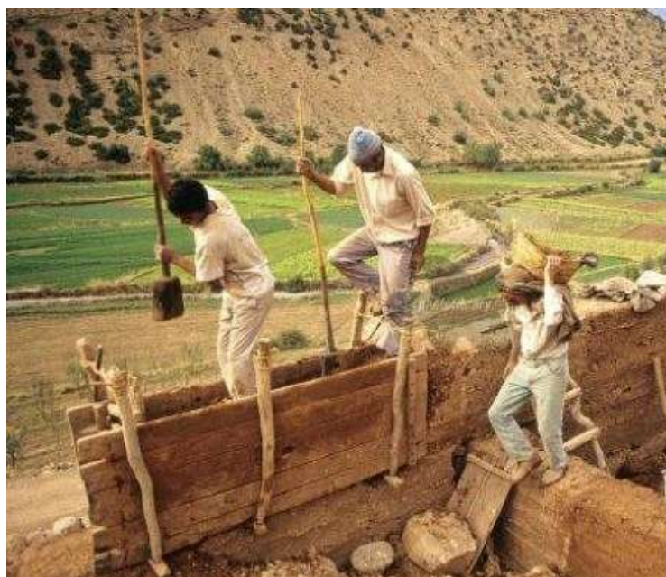
Figura10: Execução e aspecto da taipa de pilão
