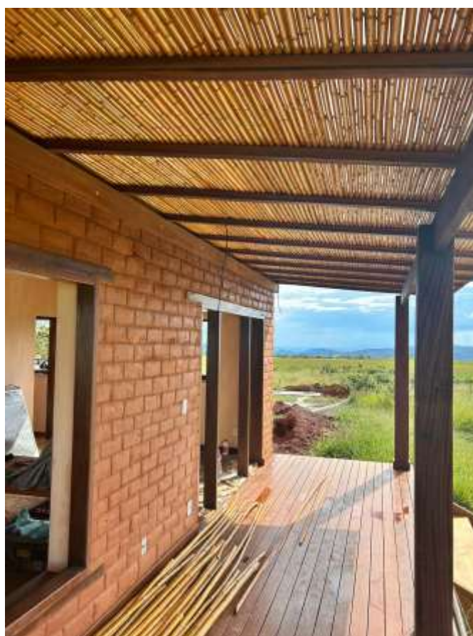
Figura14: Forro de bambu tratado, paredes em adobe e janelas de madeira de demolição.
