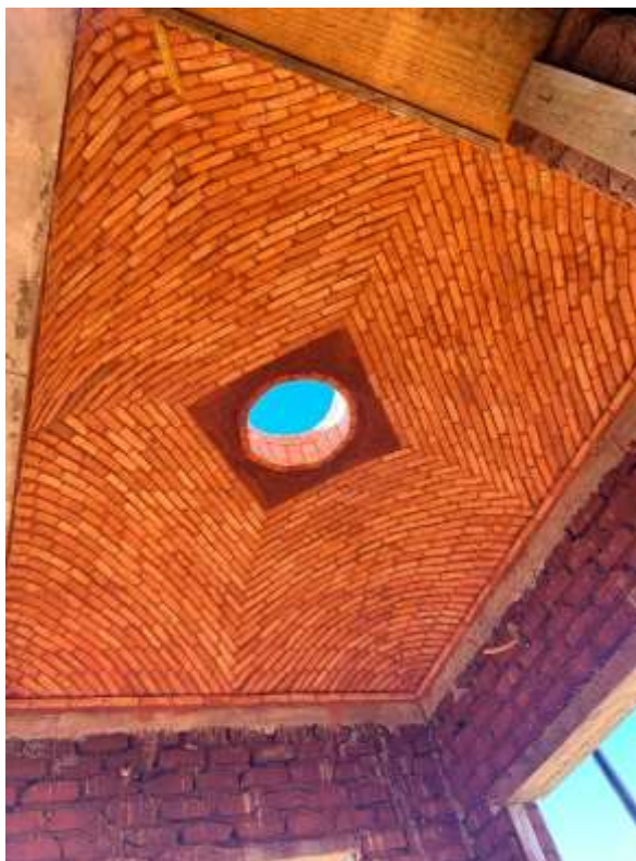
Figura17: Abóbada mexicana em tijolos de barro.
