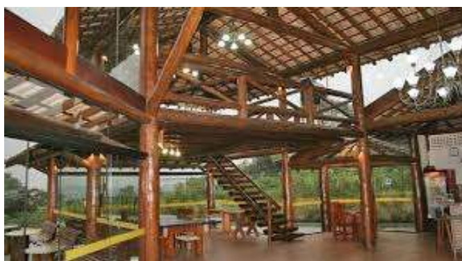
Figura 5:Emprego de madeira de reflorestamento em estruturas
