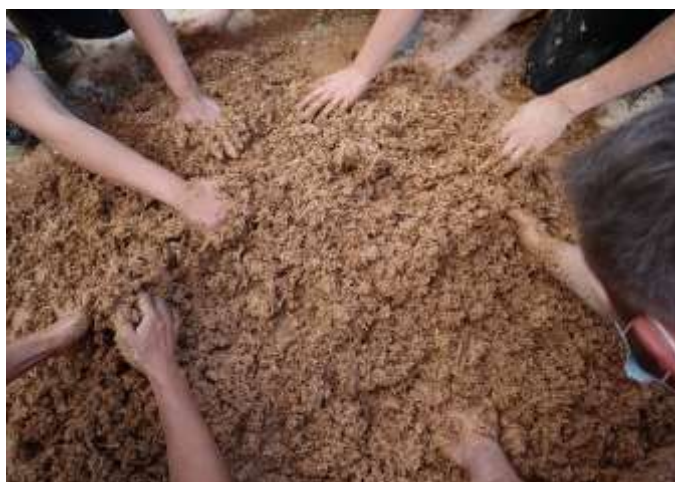
Figura 3: Terra crua em preparo para uso construtivo
