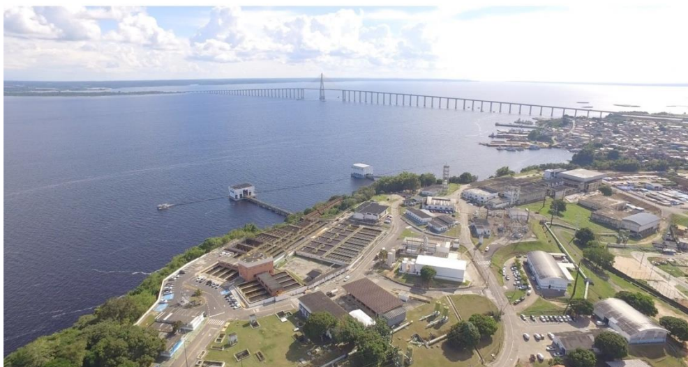
Figura 14 – Complexo de captação, tratamento e distribuição de água da Ponta do Ismael.
